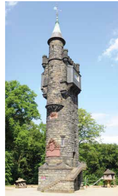
03 Weyerbuschturm auf dem Nützenberg, Quelle: Harald Stöcker, Laib und Leib Büro für Kommunikation
