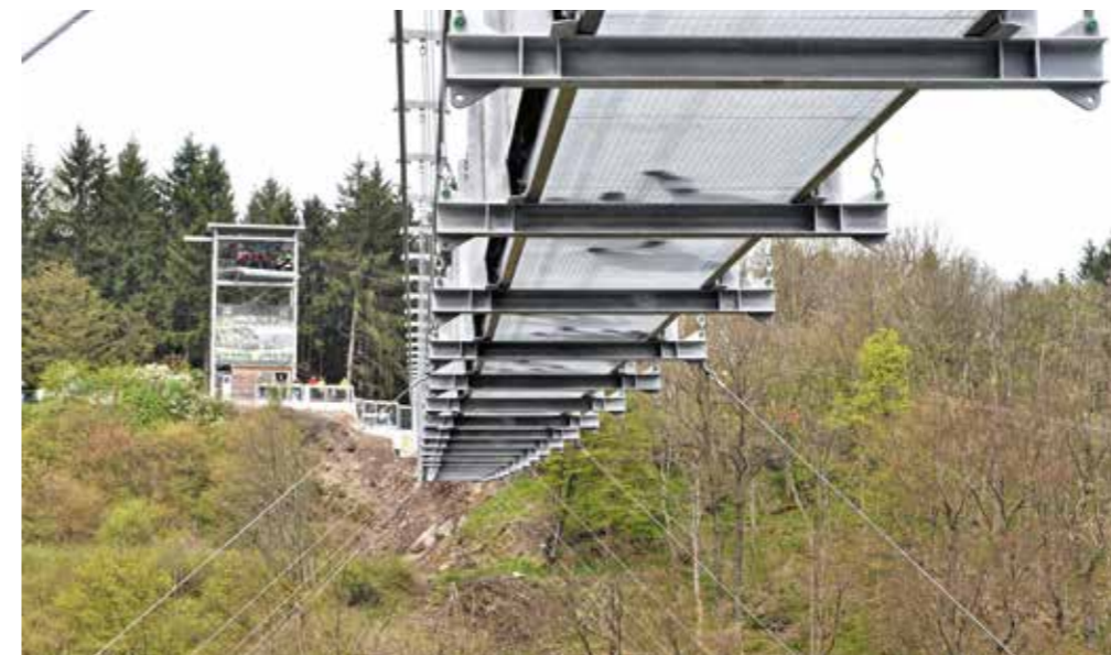
02 Brückenbauwerk, Quelle: Firma hochkant GmbH
