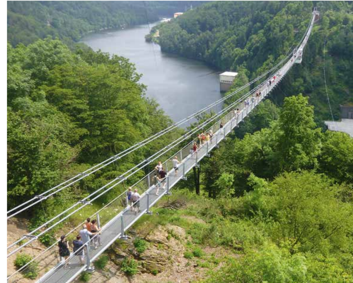
01 Ein neues Brückenbauwerk, Quelle: Firma hochkant GmbH
