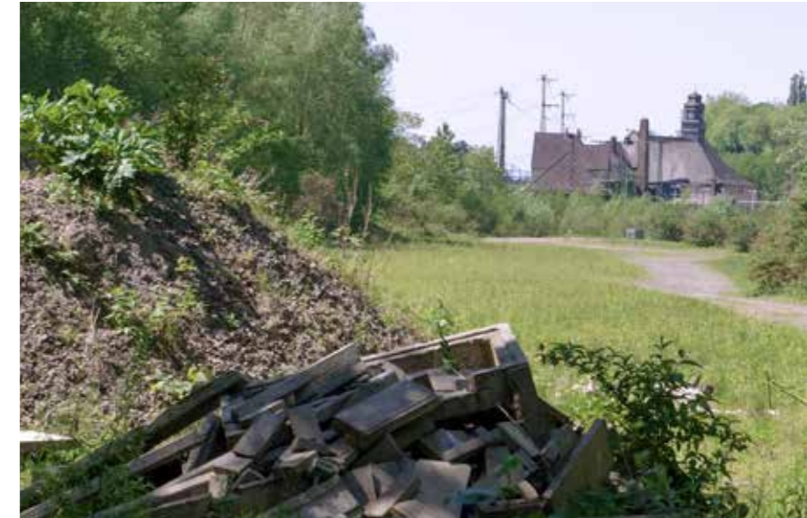
01 Blick auf das alte Lokschuppenareal in Tesche, Quelle: Harald Stöcker, Laib und Leib Büro für Kommunikation
