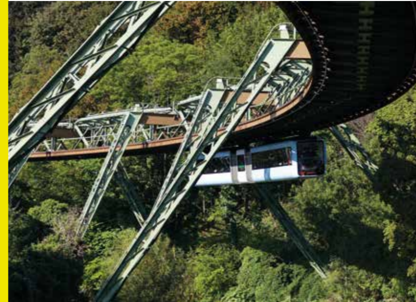
01 Die Wuppertaler Schwebebahn, Quelle: Stadt Wuppertal
